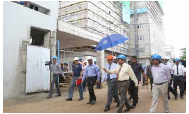
Gotabhaya inspizierte gerne und oft die Fortschritte auf Baustellen in Colombo. (Foto: Ministry of Defence and Urban Development, 2014)
